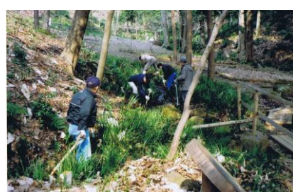
(こぶしの里の水源整備)
